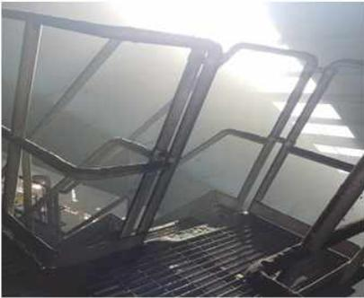
Tripper 상부 진입로 안전난간에 경사가 있어 추락 및 전도 위험이 있음.
