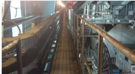
옥내저탄장 3층 CV-04F 진좌측, 옥내저탄장 1층 방수포 및 Dust Suppression 설치되어 있는 통로에 케이블 트레이만 설치되어 있고 안전난간은 설치되어 있지 않음.
