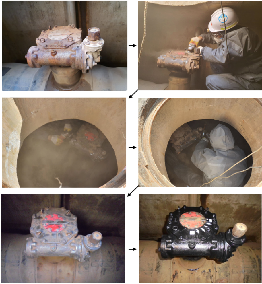
[그림 105] 맨홀작업 중 경보수 작업 순서
